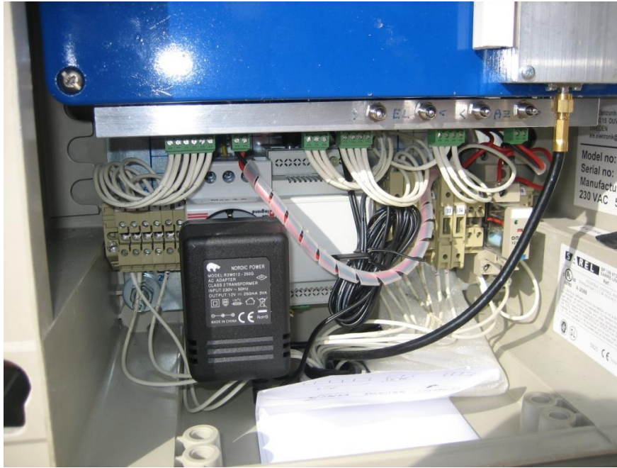
Figura 24: Módem en el extremo de Spider dentro del rack del receptor.
