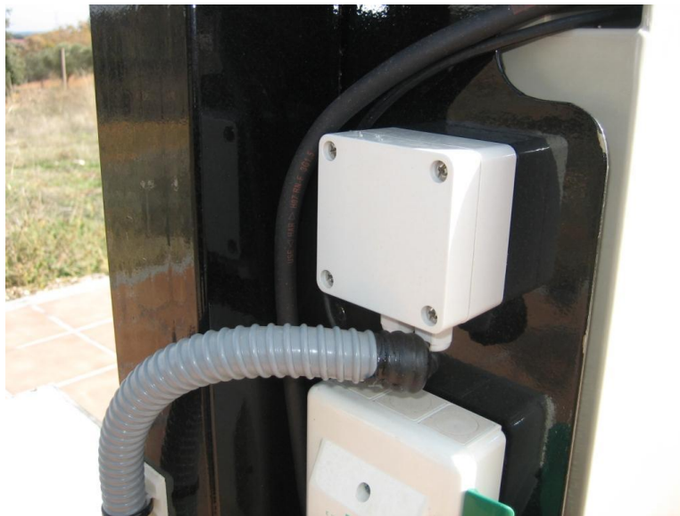
Figura 25: Entrada/salida de datos desde el rack del receptor.
