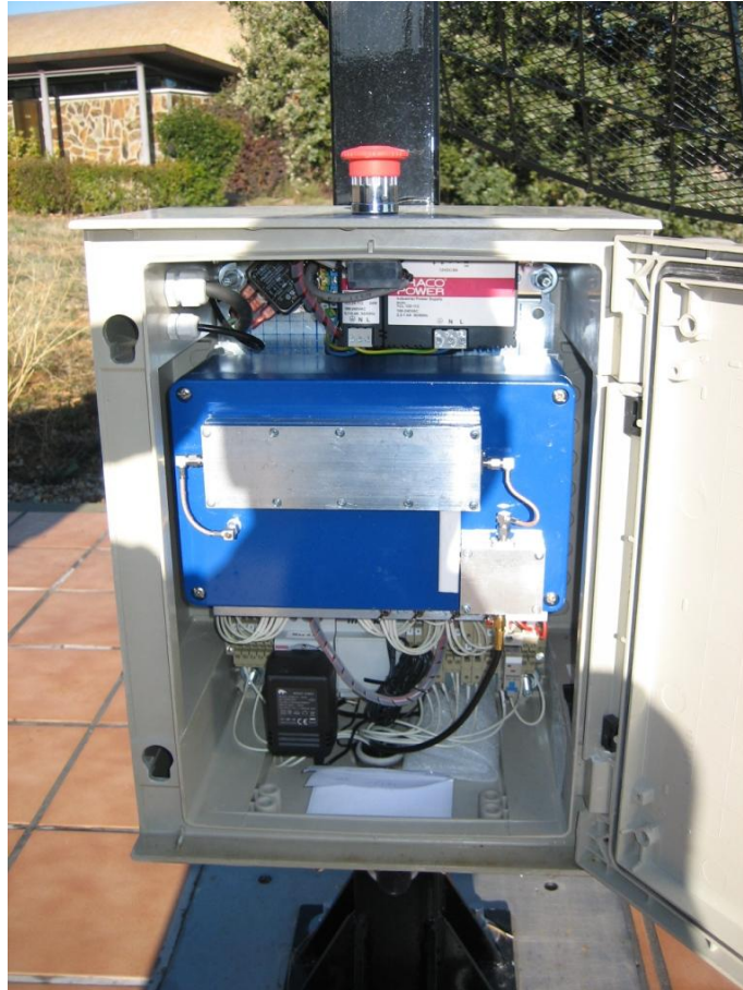
Figura 19: Receptor instalado dentro del rack en el pedestal del radiotelescopio.
