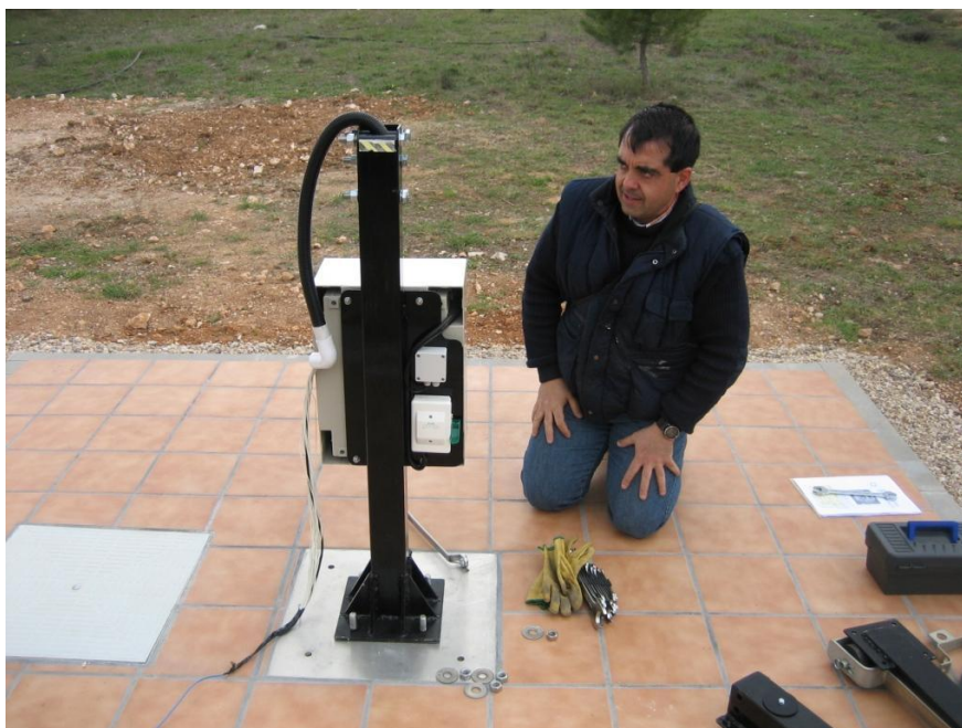
Figura 12: Fijación del pedestal del radiotelescopio (junto con el rack de alimentación, control y recepción) al pilar de sujeción en el terreno.
