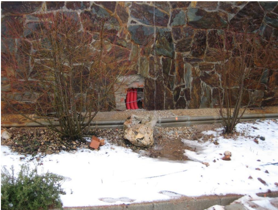
Figura 10: Zanja para los cables de alimentación, control y señal de RF.
