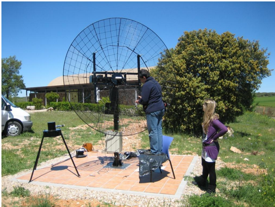
Figura 18: Proceso de instalación de la superficie reflectora (parábola) y tetrapodo con la bocina listo para su integración en el sistema.
