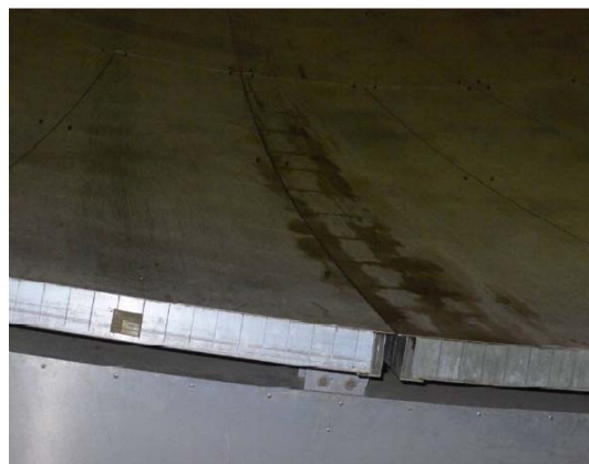
Figura 18: Detalle del estado actual de la superficie del reflector primario.
