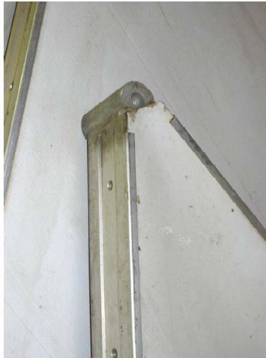
Figura 33: Detalle de un panel del radomo.
