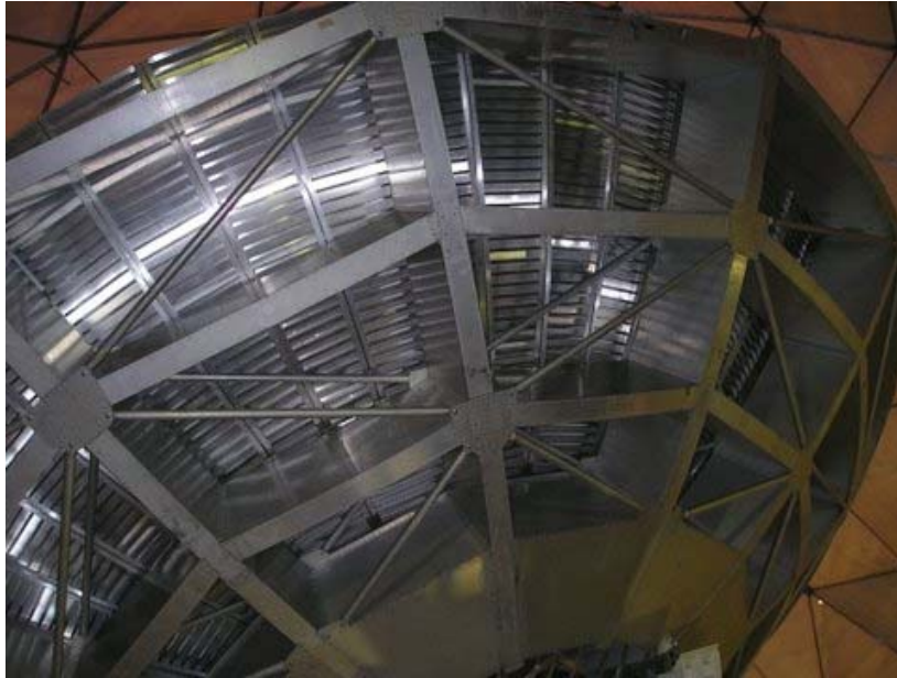
Figura 34: Brazos diagonales en la antena gemela de 14 metros de Metsähovi. 1
