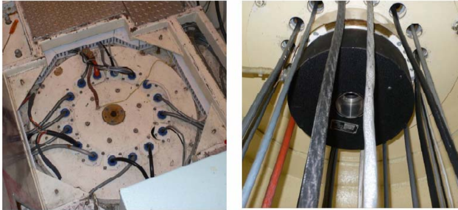
Figura 15: Bajada de cables. Parte superior (izquierda) y parte inferior (derecha)
