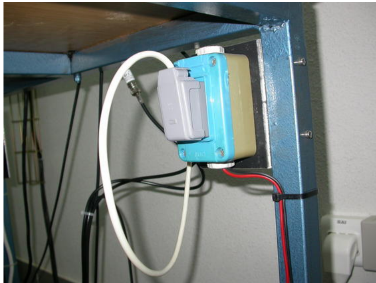
Figura 5: Detalle de la regleta en la mesa de soporte del maser. El cable que une el máser con las baterías no es directo y pasa por la regleta, lo que permitió fácilmente su prolongación.
