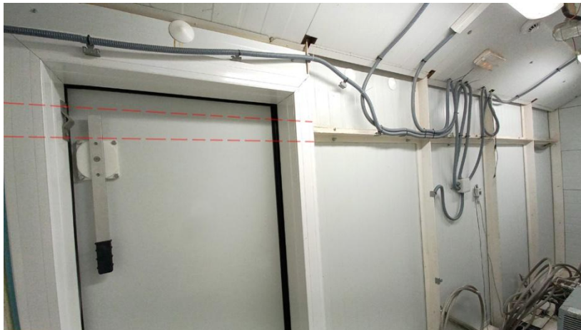
Figura 14. Frontal nuevo de la sala de compresores desde el interior.
