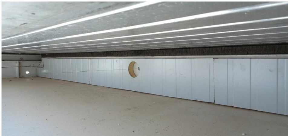
Figura 18. Aislamiento de la pared bajo la persiana del techo.
