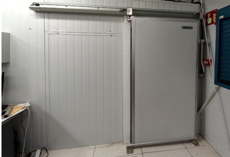
Figura 13. Nueva puerta de la sala de compresores.
