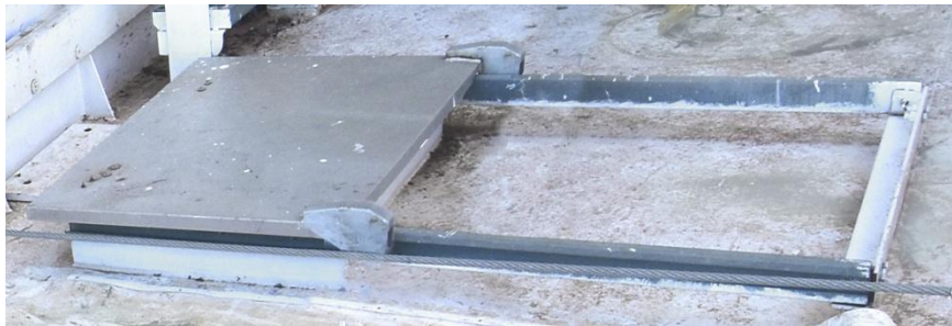
Figura 5. Trampilla del techo de la sala de receptores
