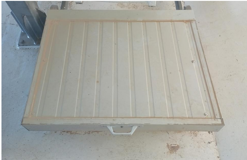
Figura 19. Trampilla recubierta del techo de la sala de receptores.
