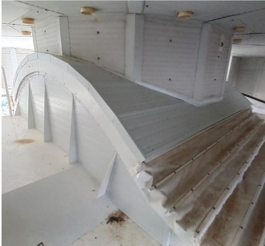
Figura 17. Aislamiento de los laterales y de la visera del tubo vértice.
