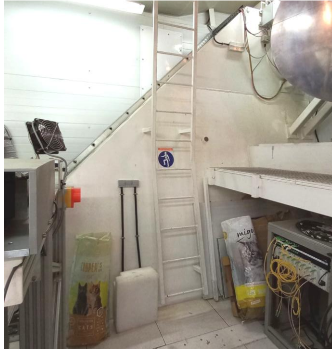
Figura 6. Estructura lateral del yugo en la sala de receptores.
