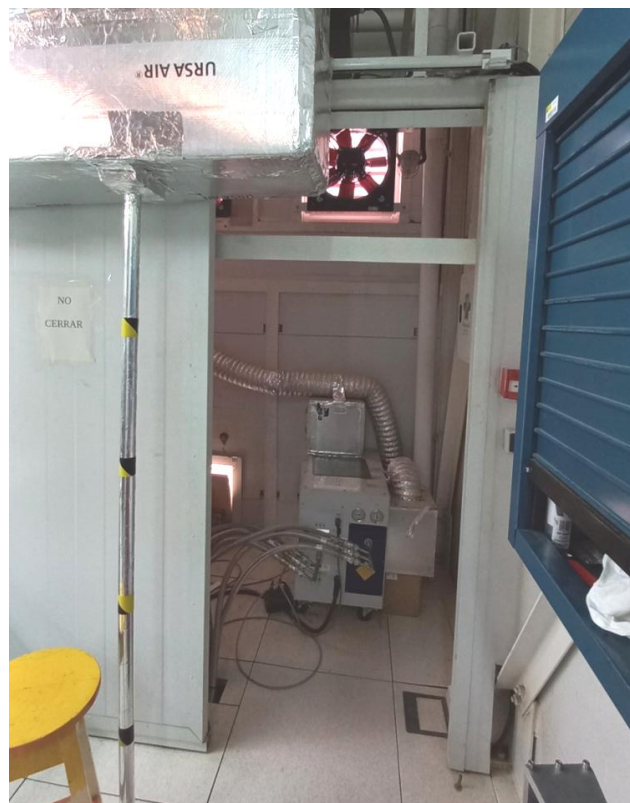
Figura 2. Puerta de acceso a la sala de compresores.
