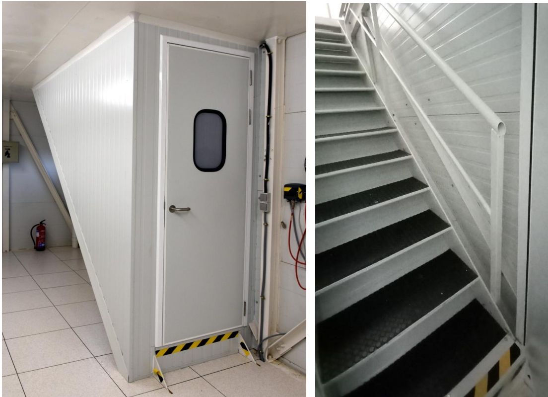
Figura 7. Cerramiento de la escalera de acceso desde la sala de servos, con detalle de barandilla y pared al exterior.
