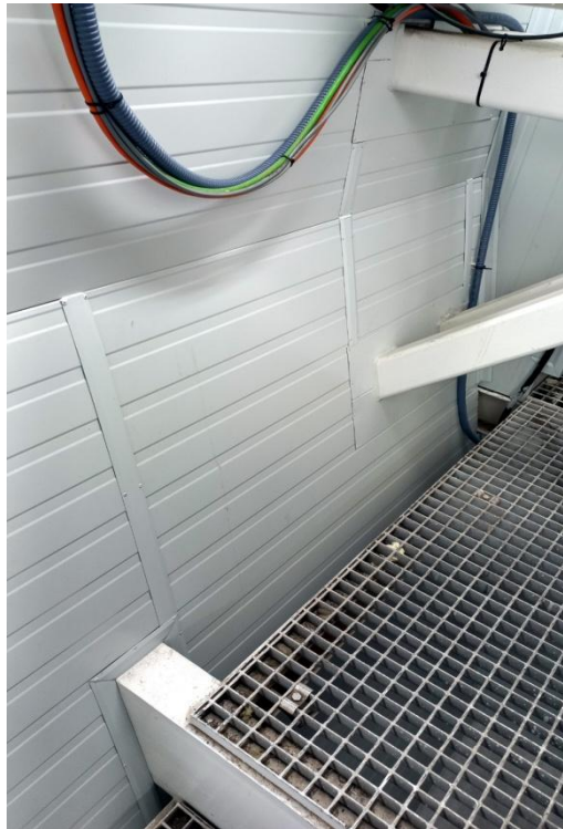
Figura 8. Detalle de los recortes realizados en el aislamiento de la estructura lateral del yugo.
