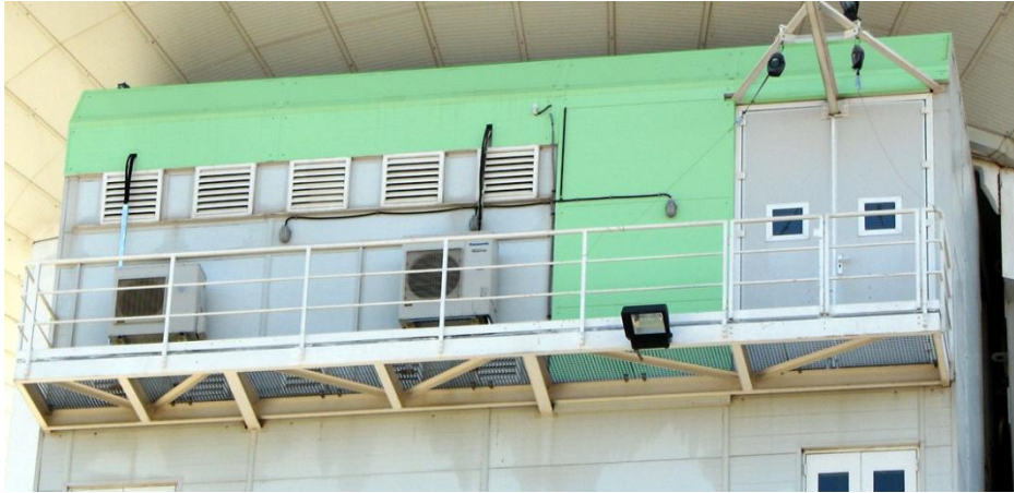
Figura 22. Aislamiento de la pared trasera de la sala de receptores.
