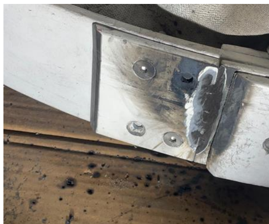
Ilustración 20. Elemento añadido para facilitar el paso de rueda horizontal.
