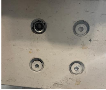
Ilustración 22. Ejemplo de unión con la cabeza del tornillo cizallada.
