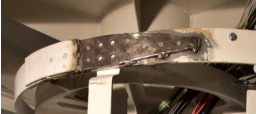
Ilustración 5. Refuerzo soldado a la pletina.
