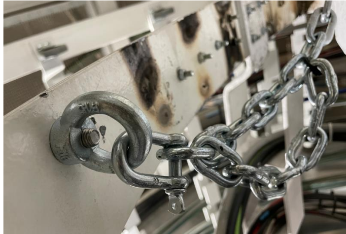
Ilustración 11. Unión pletina-cáncamo-grillete-cadena de seguridad.
