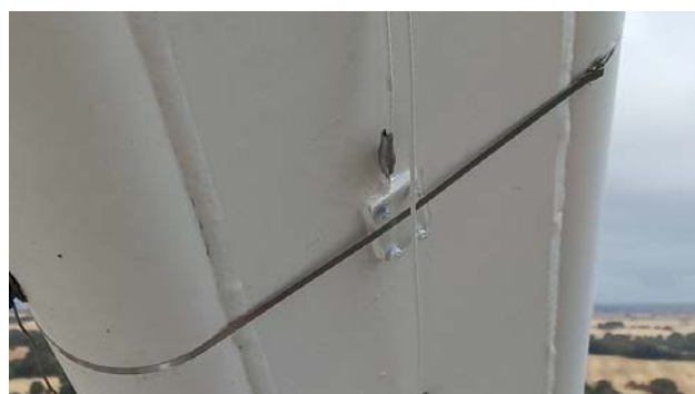
Figura 22. Ejemplo de fijación en pata del tetrápodo.
