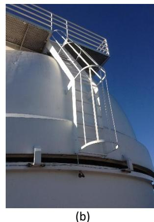
Figura A.I.6: Escalera de acceso a la cúpula (a). Dicha escalera se acopla al primer peldaño de la escalera de la cúpula. Durante el uso del astrógrafo, la escalera debe estar retirada y tumbada en la terraza, tal y como se muestra en la figura A.I.6a. **NO INTENTE SUBIR A LA CÚPULA.**
