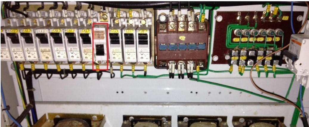
Figura 2.1.1: Magnetotérmico del motor de seguimiento (velocidad constante ajustada por un variador instalado en la parte trasera del bastidor) para la compensación de la rotación de la tierra, marcado con el recuadro rojo.
