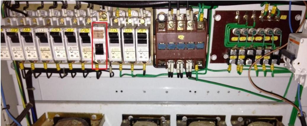
Figura A.I.8: Magnetotérmico del motor de seguimiento (velocidad constante ajustada por un variador instalado en la parte trasera del bastidor) para la compensación de la rotación de la tierra, marcado con el recuadro rojo.
