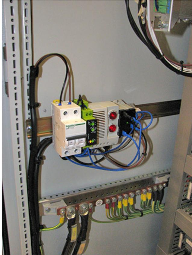
El suministro eléctrico se ha tomado del terminal –XP328 del cuadro eléctrico, que da servicio también al equipo de climatización de la cabina. Los calefactores se conectan a un terminal numerado con las conexiones indicadas en la tabla siguiente. La línea se bifurca en una caja de conexiones situada bajo el suelo técnico de la cabina, de donde sale una línea independiente para cada uno.
