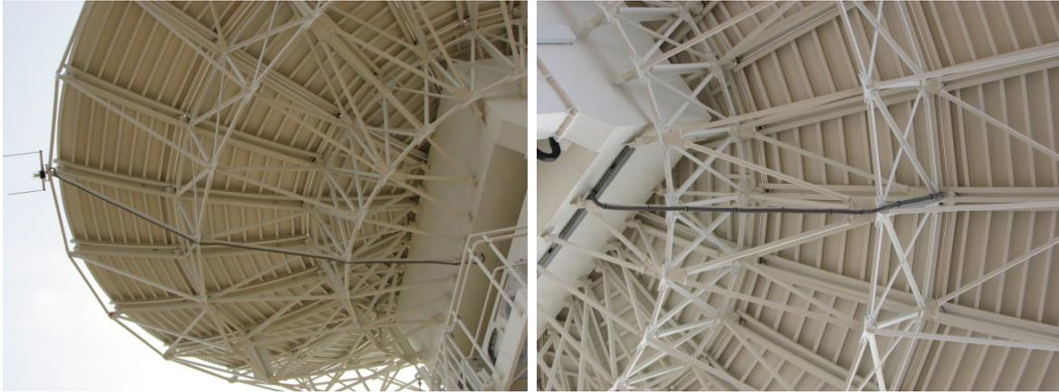
Estos conductos han tenido que ser reconducidos por la parte interior de las vigas, dejando libre la superficie para fijar los perfiles.
