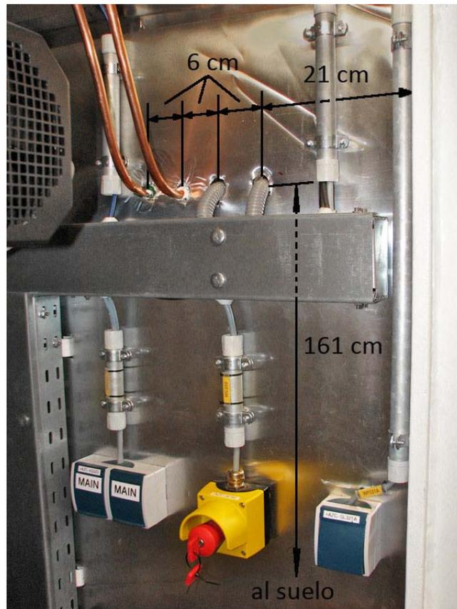
**Figura 11.** Orificios en pared para tendido a caseta del compresor.
