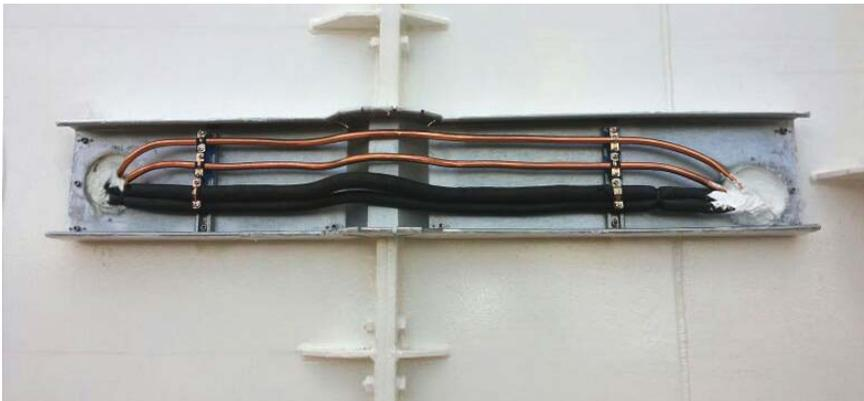
Instalación en la canaleta exterior. La cabina de elevación está a la derecha.
