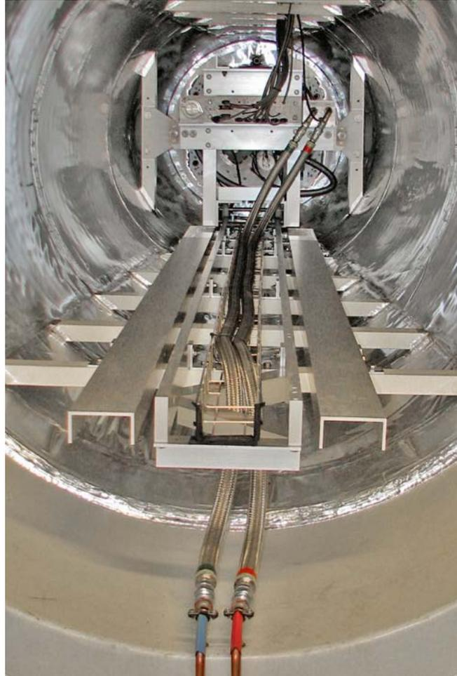
**Figura 2.** Tramo de tubos de Helio en el tubo cónico.
