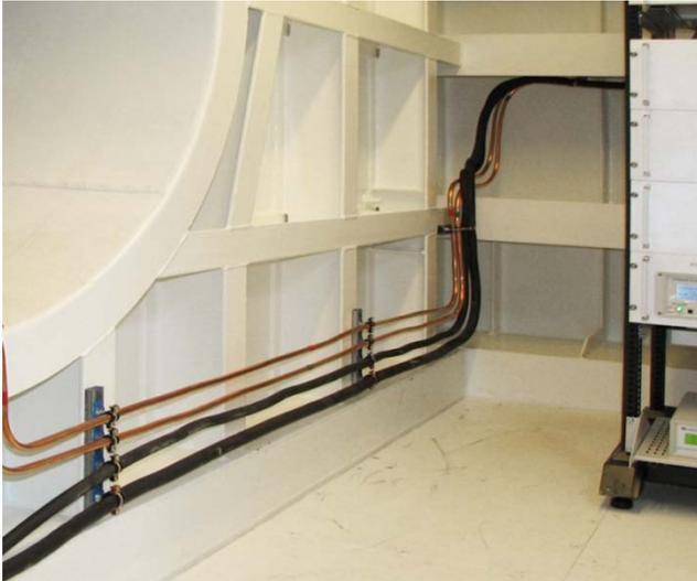
Tendido a lo largo de la cabina de elevación. Se observan los tres puntos de anclaje a la pared.
