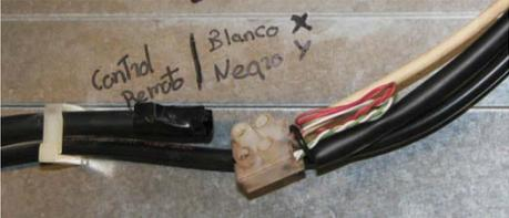
Conectar el cable cortado que viene de la placa de control al cable del controlador remoto.
