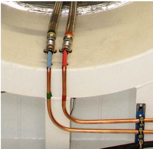
Conexión de los tubos semirígidos a los tubos flexibles en el tubo cónico. Se observa la primera fijación a la pared de la cabina de elevación.
