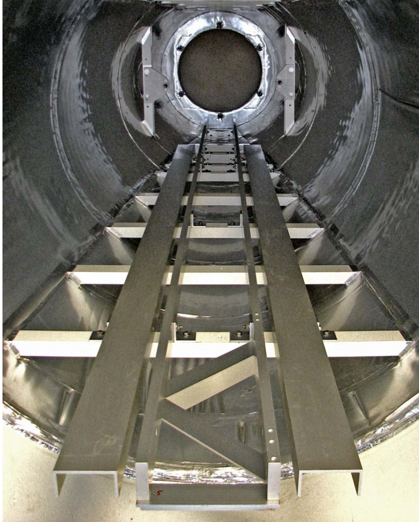
Figura 22. Instalación de raíles, pasarelas y pines en el tubo.
