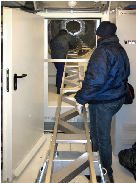
Figura 26. Conexión de la extensión con los raíles del tubo.
