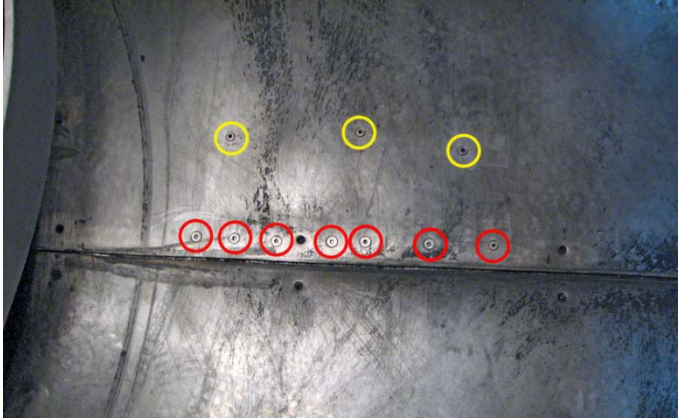
Figura 17. Estado de la chapa-D tras ser atornillada
