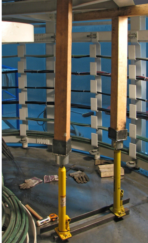
Figura 18. Montaje para doblar las chapas con dos gatos.
