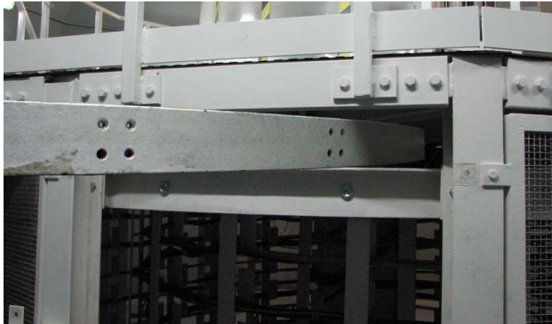
Figura 25. Extracción de la pletina del enrollador..
