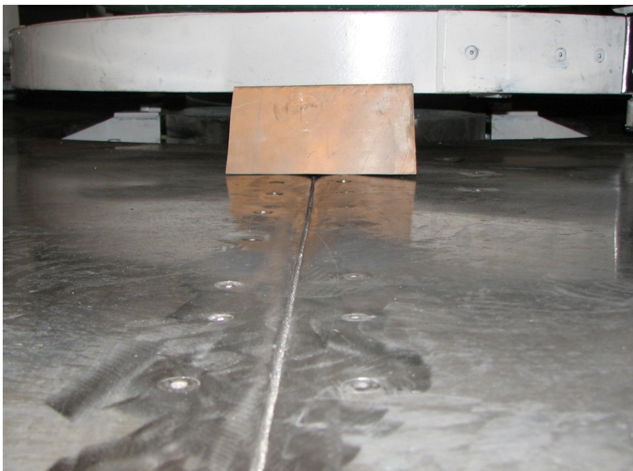
Figura 19. Estado de la junta-1 tras los trabajos.
